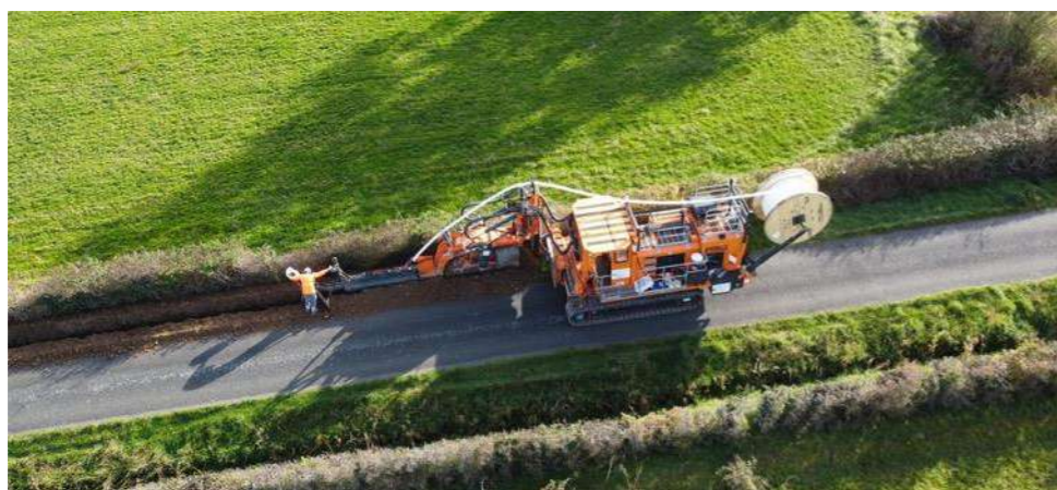
Photos 36 : Pose des lignes souterraines (source : CEGELEC)
